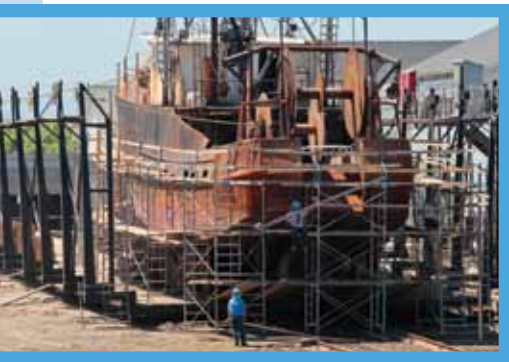
Des réparations sont effectuées au chantier naval d'A.F. Theriault et Fils Ltée à La Butte, en Nouvelle-Écosse.
